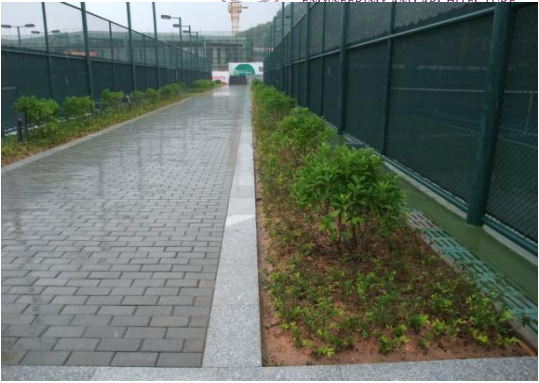
透水铺装地面和下沉式绿地
