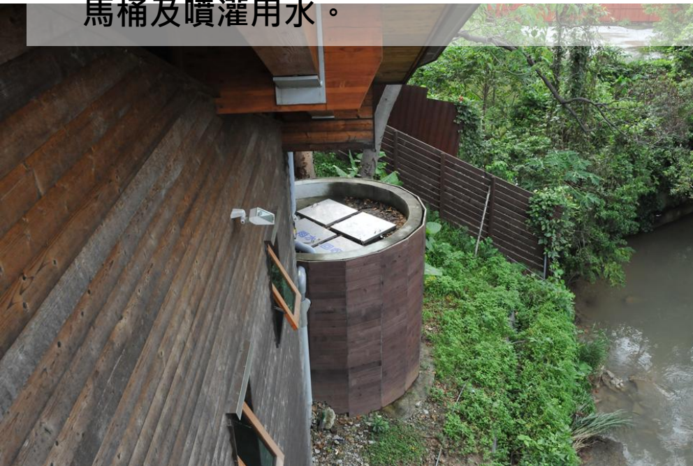
設置雨水回收系統
