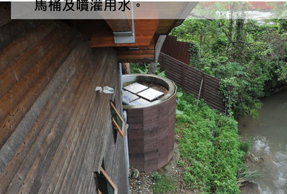
設置雨水回收系統
