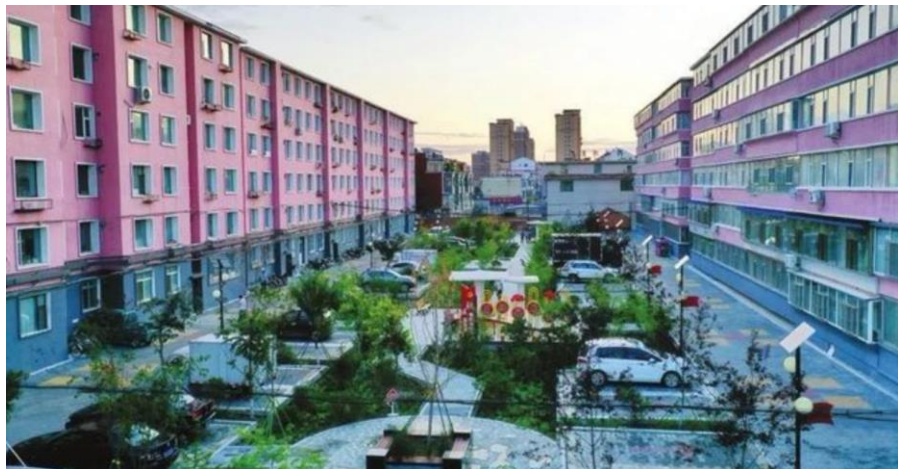
白城市海绵城市建设暨老城区综合提升改造工程
