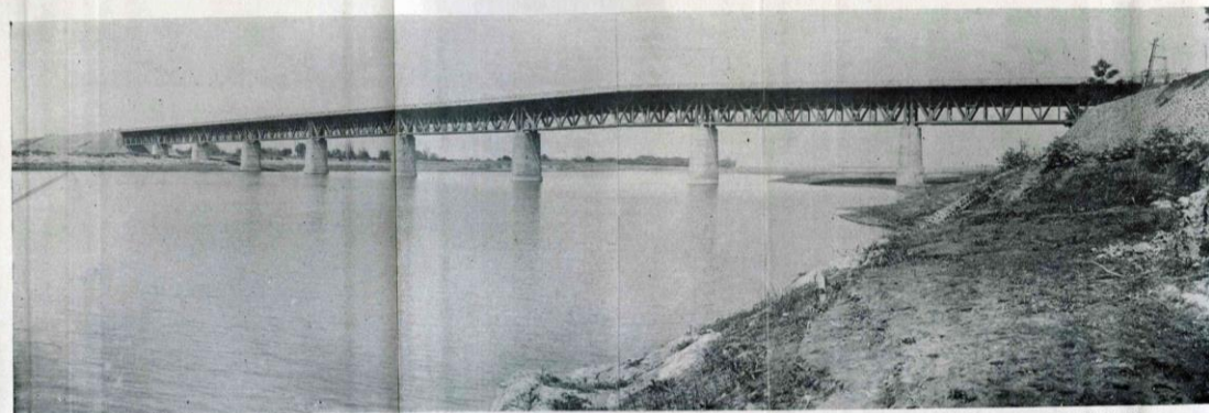
【曾文溪水橋】曾文溪水橋は曾文郡官田庄三塊厝と新化郡高化庄東勢寮の間に於て給水路南幹線を連絡するため曾文溪上に架設せるものにして、橋體構造は「ワーレン・トラス」型とし、橋長一千百十九呎、橋桁中心幅十三呎六吋、橋桁高十七呎、徑間長百二十呎、九連、橋脚構造は立上りを鐵筋混凝土造、基礎を鐵筋混凝土造積圓形井筒とし、立上り高三十呎八寸乃至三十二呎三寸、井筒長四十五呎乃至六十一呎、十基、水路橋構造は鋼製製箱型とし、高八呎、幅十呎、勾配五百分の一最大流量七百二十五立方秒尺を有す。而して本水橋上端は本島縦貫道路とし路面幅二十一呎、兩側高欄高三呎五寸、道路敷及高欄は何れも鐵筋混凝土造とす。
