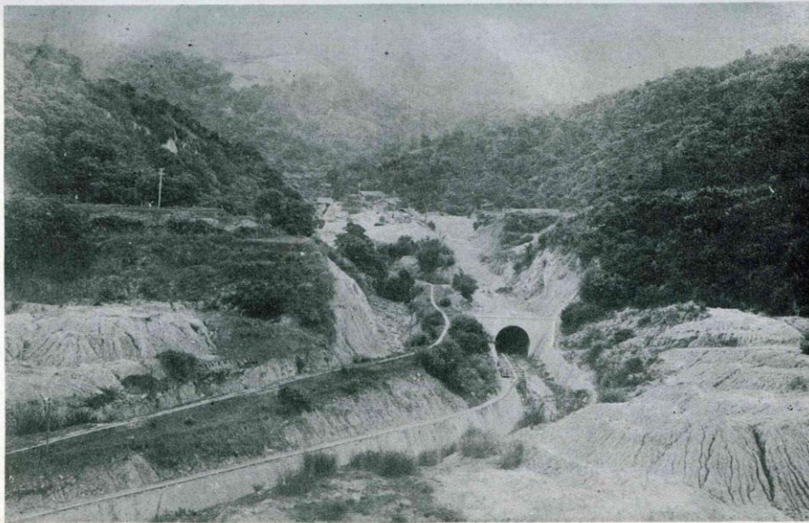
【烏山嶺取入隧道出口附近】 烏山嶺取入隧道は曾文溪取入口に依りて取入れたる水量を官田溪上流に送水するものにして、隧道構造は高十八尺幅十八尺馬蹄形、仰拱及拱座を混凝土造、拱及側壁を煉瓦造とし、延長一千七百十間勾配一千二百分ノ一最大流量一千八百立方秒尺を有す。
